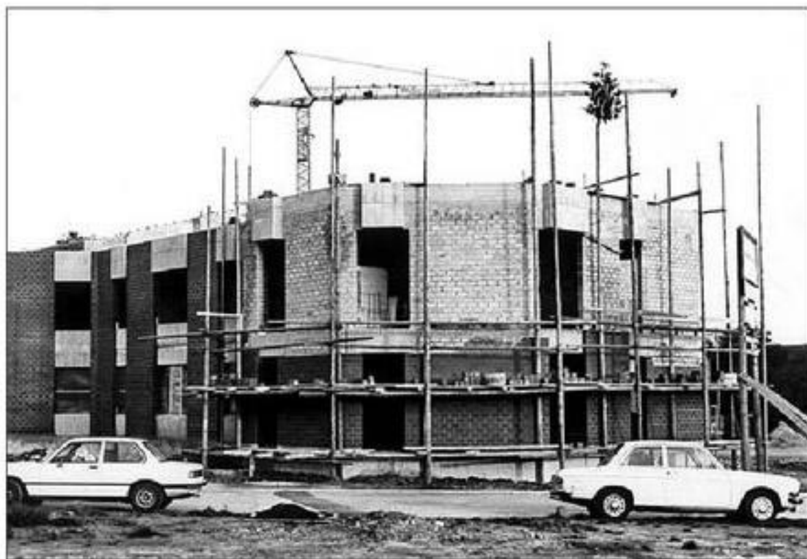
Die Dalheimer „Cerisaie“ während der Bauarbeiten.
